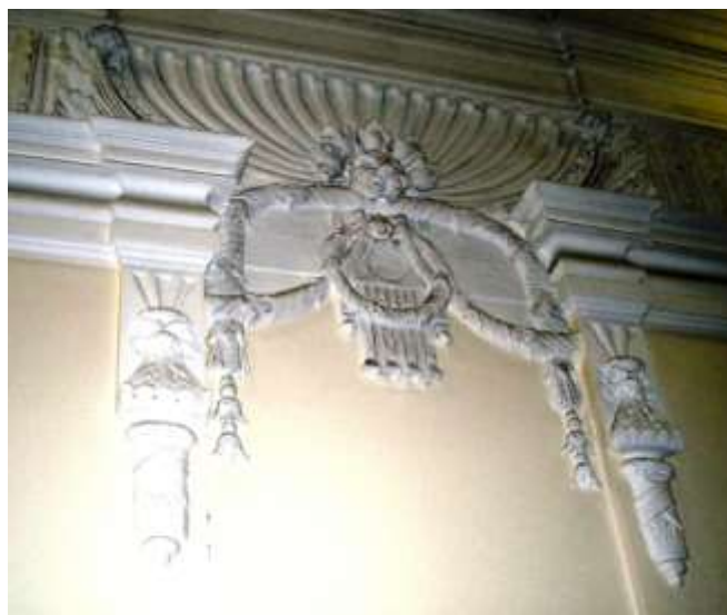
Dettaglio del fregio in stucco di gusto eclettico della Sala Scacchiera
